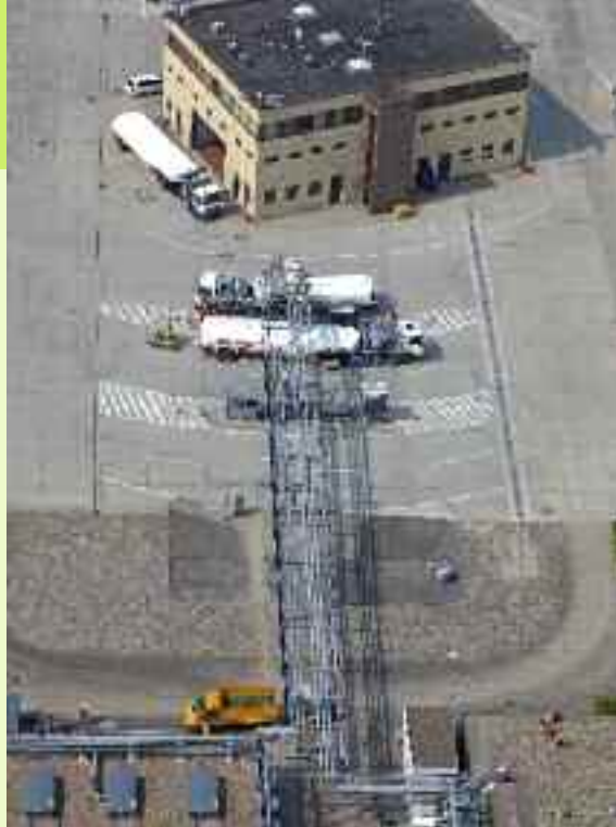
Das zentrale Kerosinlager unterliegt sehr strengen Sicherheitsvorkehrungen
