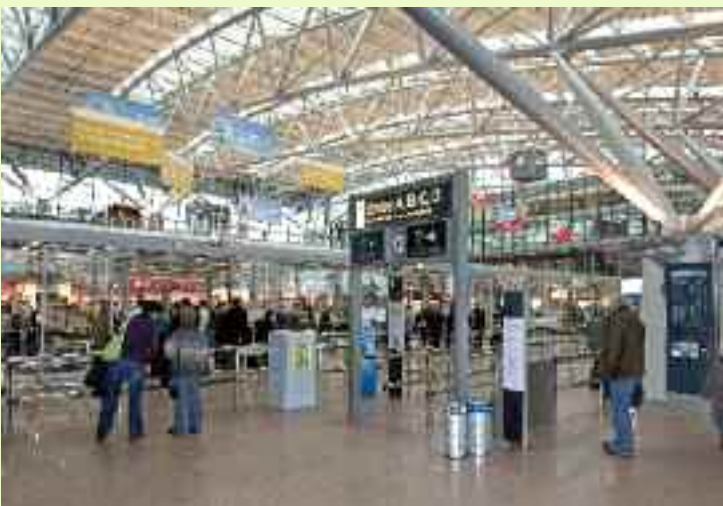
Die FHG betreibt neben den Terminals eine Vielzahl anderer Gebäude
